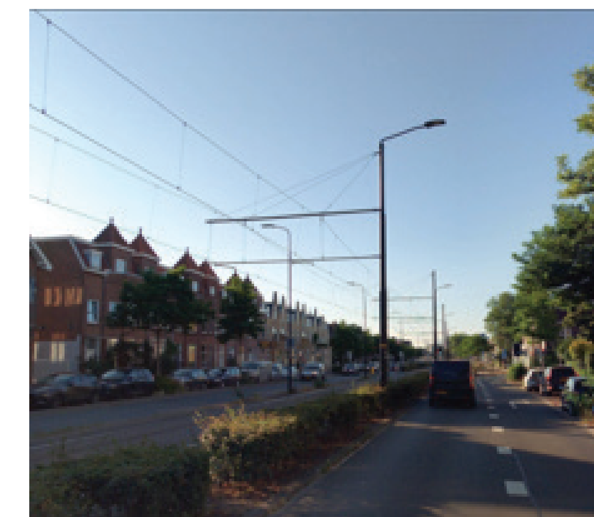
Voorbeeld enkele zijmast
